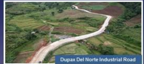
FMR in Brgy. Nagpanaoan, Santa, Ilocos Sur
